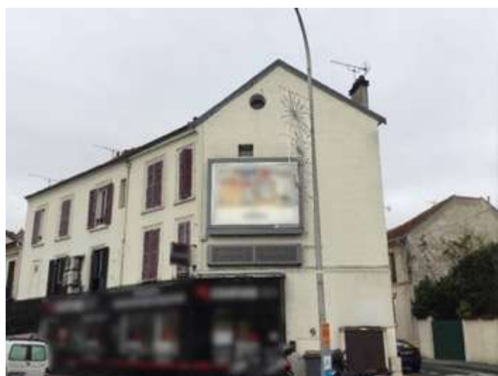
Exemple de dispositif publicitaire apposé au mur avec passerelle – Le Perreux-sur-Marne – 2019
