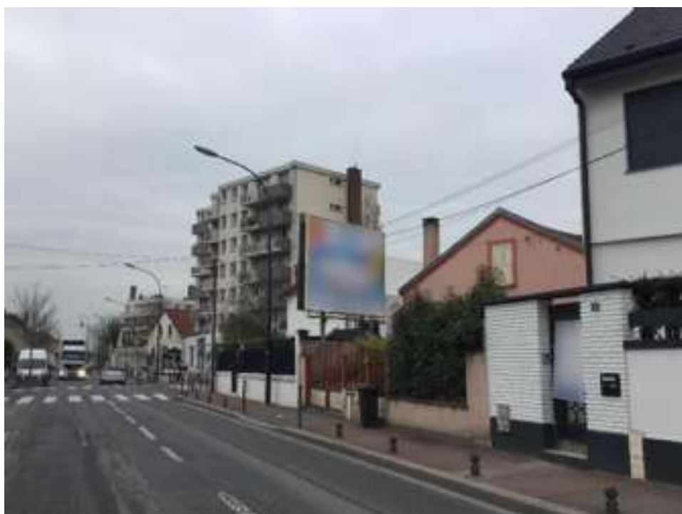
Dispositif publicitaire scellé au sol dont le recul par rapport à la propriété voisine est inférieur à la moitié de la hauteur du dispositif –Saint-Maur-des-Fossés - 2019
