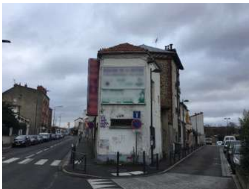
Dispositifs publicitaires apposés au mur parfois en mauvais état d'entretien – Fontenay-sous-Bois – 2019
