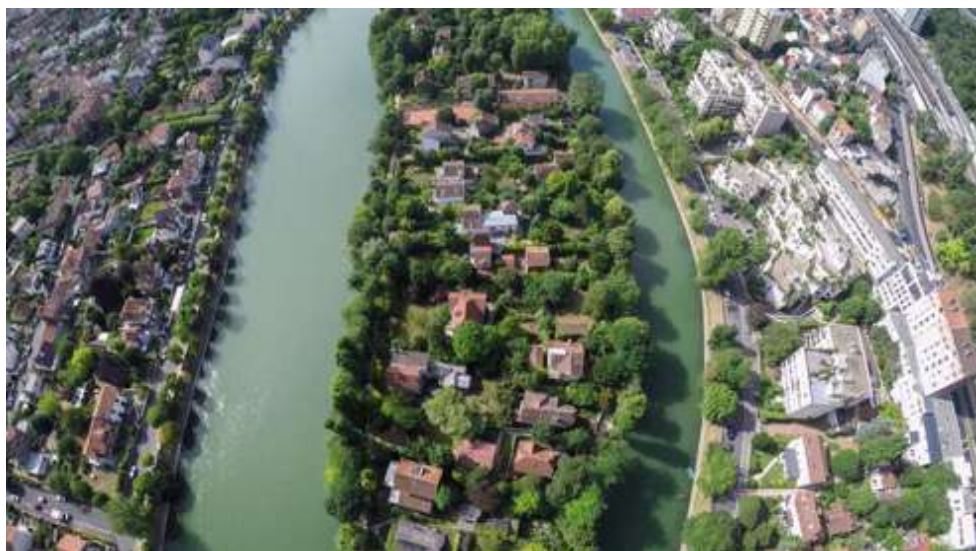
Vue de l'île Fanac, Joinville-le-Pont
